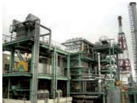
「バイオマス発電」設備
