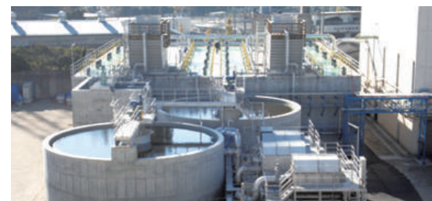
再利用水処理設備
