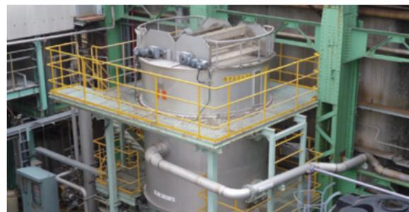
水処理設備(加压浮上装置)
