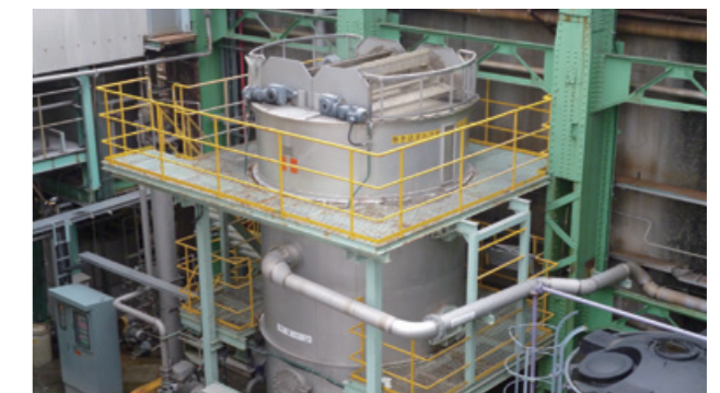
水処理設備(加圧浮上装置)
