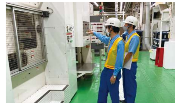
安全衛生パトロールの様子
