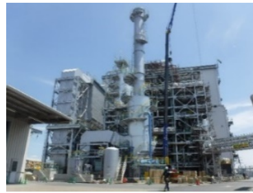
バイオマスボイラ
