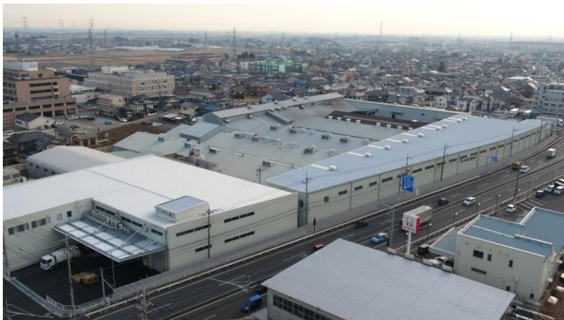
道路沿い右手が貼合工場棟、左手が事務所倉庫棟
