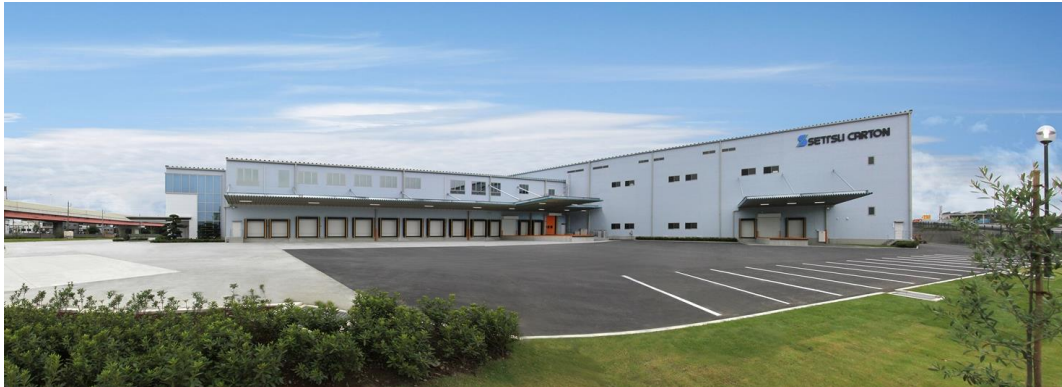
セツカートン(株)新東京工場
