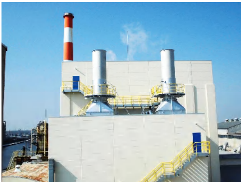
ガスタービン建屋全景
