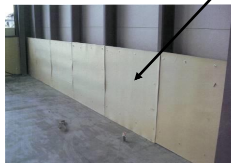
四周の外壁に施工
