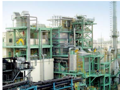
バイオマス焼却発電設備
