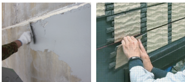
施工時の様子(左:複合した塗材の壁面塗布の様子 右:タイル貼りの様子) 写真提供:株式会社タイルメント様
