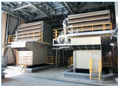
◎尼崎工場 ガスタービン発電設備
