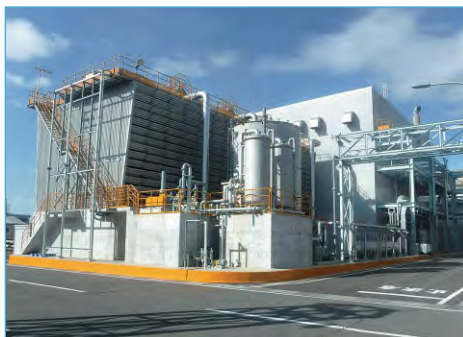
◎金津工場 蒸気タービン発電設備
