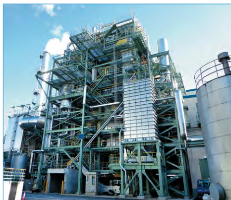
◎八潮工場 木質チップバイオマス発電設備
