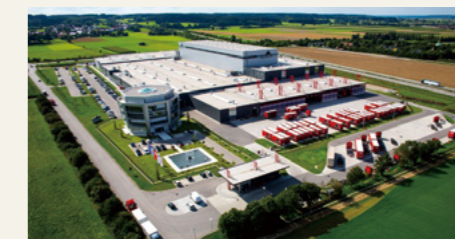
トライコー社本社工場全景
