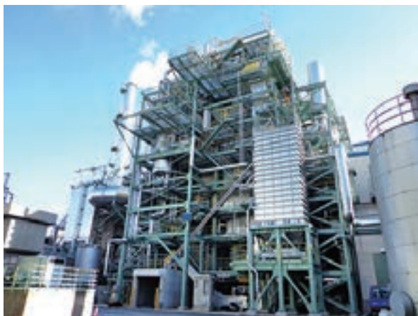
八潮工場 木質チップバイオマスボイラ発電設備
