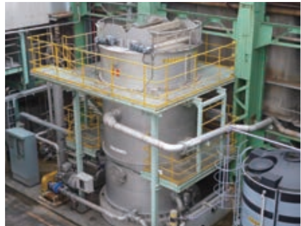
水処理施設(加压浮上設備)
