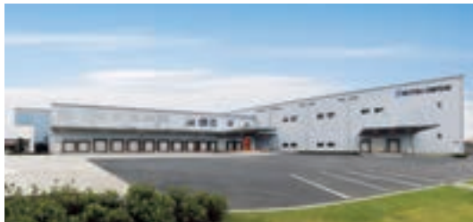
セツカートン(株)新東京工場
