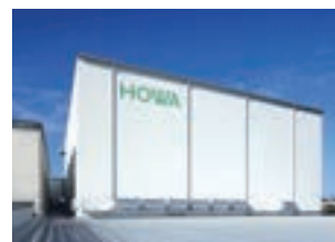
朋和産業(株)干潟工場 自動倉庫棟
