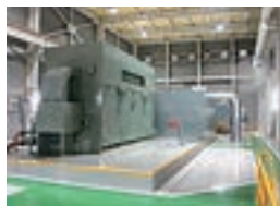
金津工場 蒸気タービン発電設備
