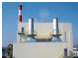
尼崎工場 ガスタービン発電設備
