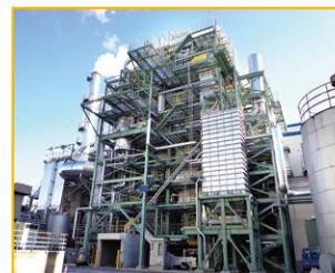
●八潮工場の木質チップバイオマスボイラ 発電設備
