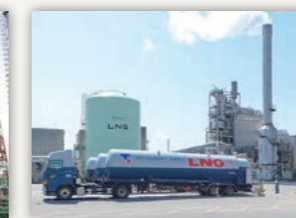
Boiler fuel LNG at Tonegawa Division
