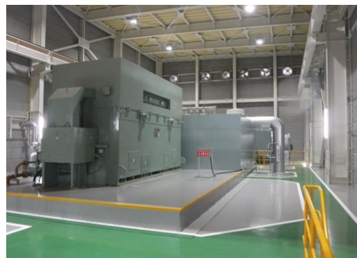
4号蒸気タービン発電設備
