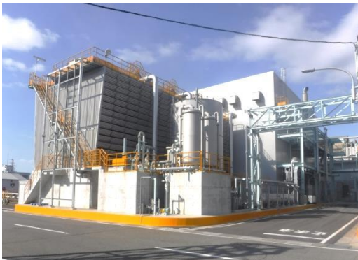
タービン建屋全景
