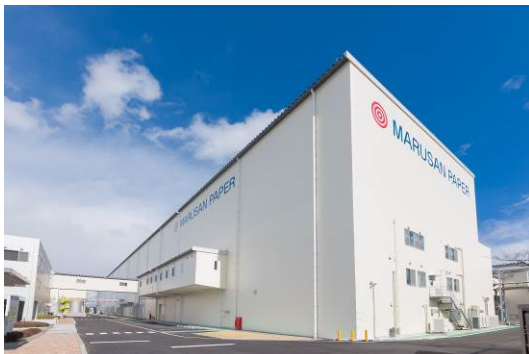
新8号抄紙機建屋外観
