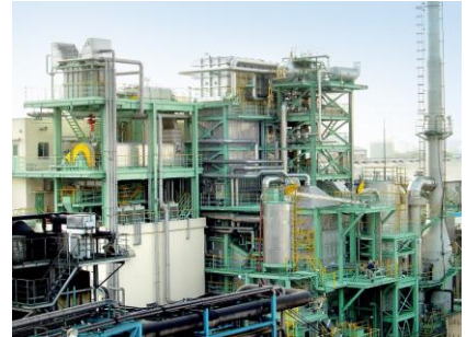
バイオマス焼却発電設備
