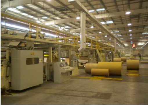
コルゲータ付近
