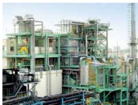
八潮工場バイオマスボイラー
