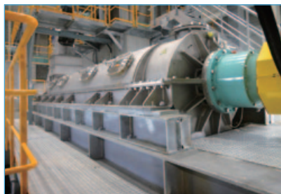
◎原質工程に新たに導入されたスクリュープレス
