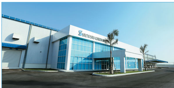
◎セツカートン・ベトナム社新工場
